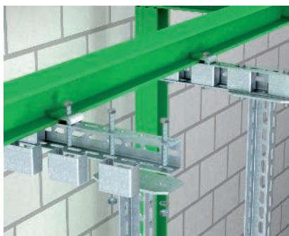
Kragträger mit Hängestiel An Stahlträger geklemmter Kragträger aus U-Stiel-Konstruktion für die Montage von Hängestielen.
