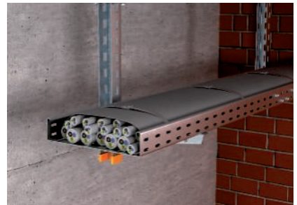
A kábeltöveg bandázsolása a tartószerkezeten.
