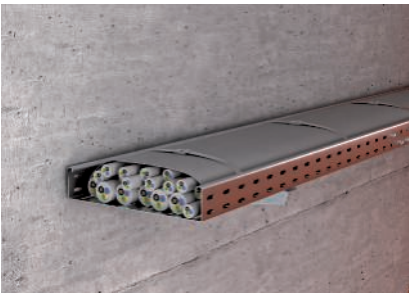
A bandázs rögzítése fém kötözővel, profil-sínes kábelhelyezés esetén.
