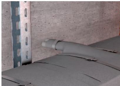
Kábelkiállítás bandázsolással.
