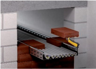
A méretre vágott blokkok beépítése.
