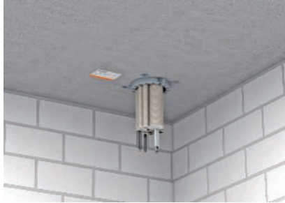
Szerelés a födém alsó részén, fémdübel-ekkel.
