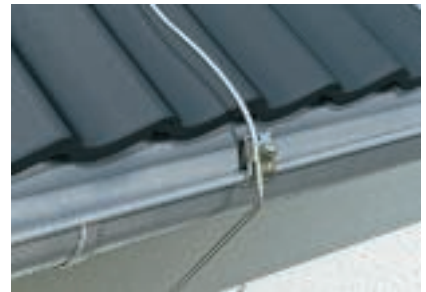
Levezető, ereszcatorna-kapoccsal
