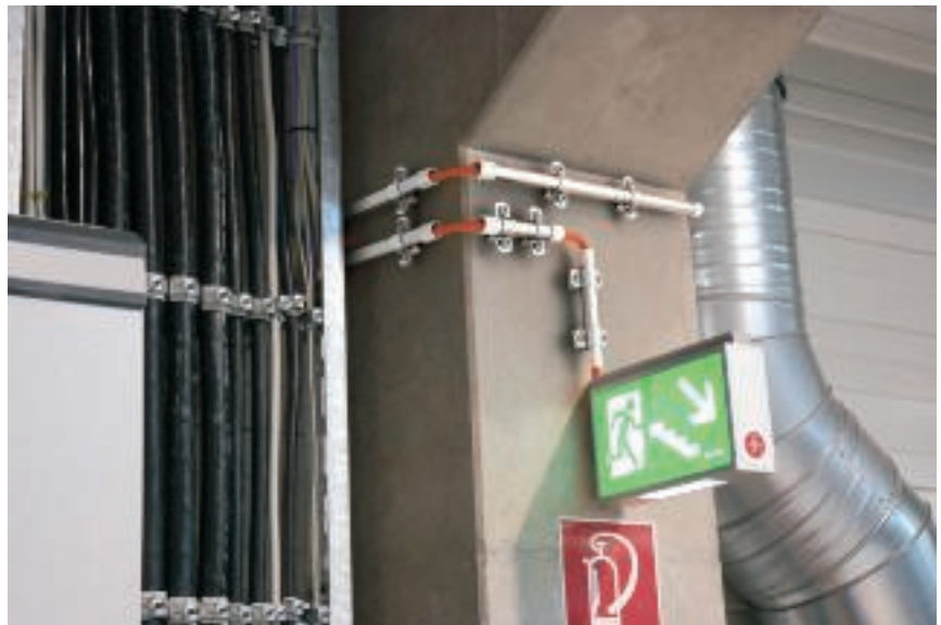
Védőcső fémből: a legjobb választás az ipari környezetben szükséges védelemhez
