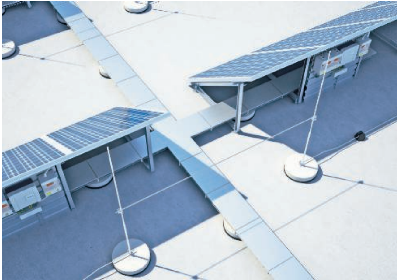
Elszigetelt villámvédelem és kábeltartó-rendszer TrayFix-szel és szerelőtalppal, lapostetőkön
