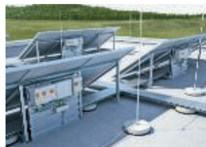
Elszigetelt villámvédelmi rendszer és 1+2. típusú SPD az inverternél
