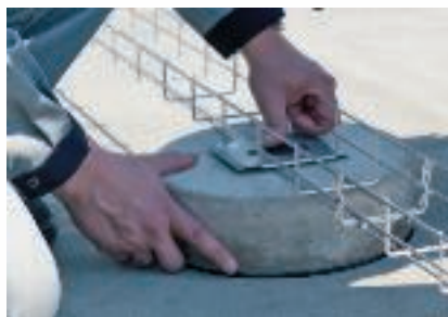
Helyezze fel a TrayFix szerelő adaptert és a rögzítő lapot, nyomja a helyére - és máris kész.
