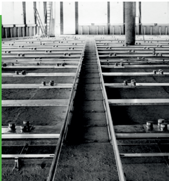
A Hamburg-Mannheimer Biztosítótársaság székházának építkezése, az EÜK-rendszer fektetése és beépítése
