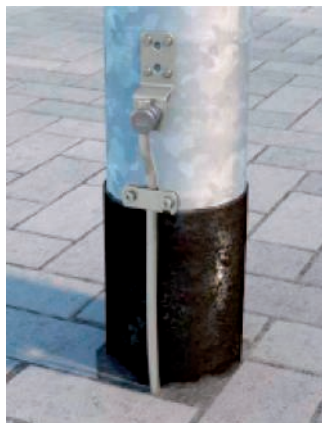
Lámpaoszlopnál történő földelés, pl: megvilágítási szint CE5
